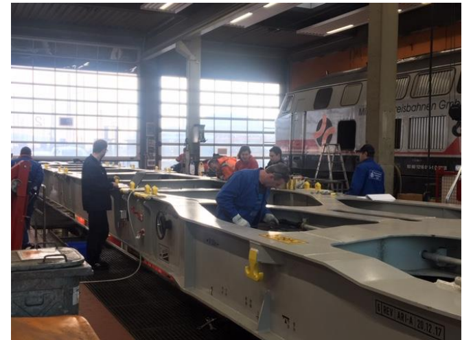
Rechts oben: Einbau BMS in Wegberg-Wildenrath, Januar 2018
